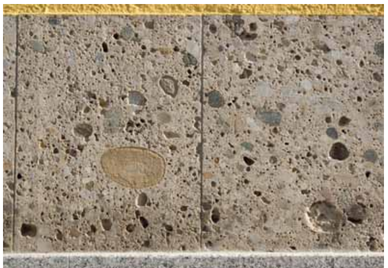
▲ Abb. 7. Sockel aus Brannenburger Nagelfluh am Gebäude des Café Schmidt mit einem Streifen von Rosa Sardo-Granit an der Basis. Bildbreite: ca. 1 m. Foto: G.L.
