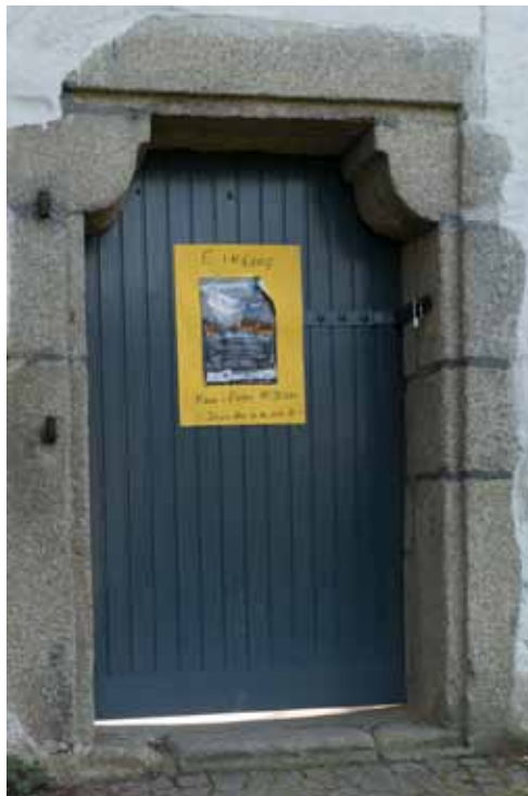
► Abb. 5. Gotisches Portal aus Mettener Granit an der Nordseite des Salzstadels an der Donau mit einer Eintiefung zum Einsetzen von Holzplatten gegen Hochwasser.
