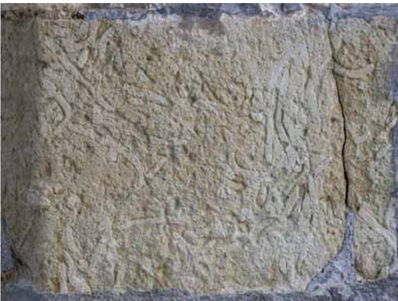
▲ Abb. 9 (oben). Durchgang unter dem Stadtturm von der Nordseite. Das Gewölbe besteht aus Blöcken von Regensburger Grünsandstein, der stark überstrichen ist und daher an manchen Stellen wie ein Kalkstein aussieht. An vielen Blöcken sind Steinmetzzeichen zu erkennen. Foto: G.L.
