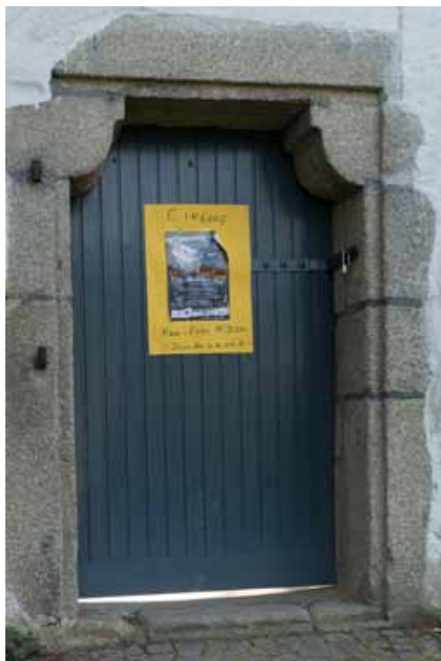
► Abb. 5. Gotisches Portal aus Mettener Granit an der Nordseite des Salzstadels an der Donau mit einer Eintiefung zum Platten gegen Hochwasser.
