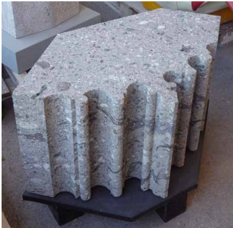
▲ Abb. 3. Profiliertes Stück aus Seelbronner Suevit aus der Werkstatt Fa. Wittner für den Einbau in der Kirche St. Georg in Nördlingen (POSCHLOD 2018).
