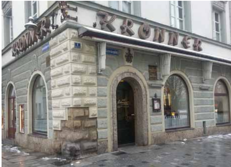
▲ Abb. 18. Fassade des Hauses Krönner an der Ecke Stenergasse – Theresienplatz mit Sockeln und Portallaubung aus Brannenburger Nagelfluh und Buckelquadern aus Mettener Zweiglimmergranit.
