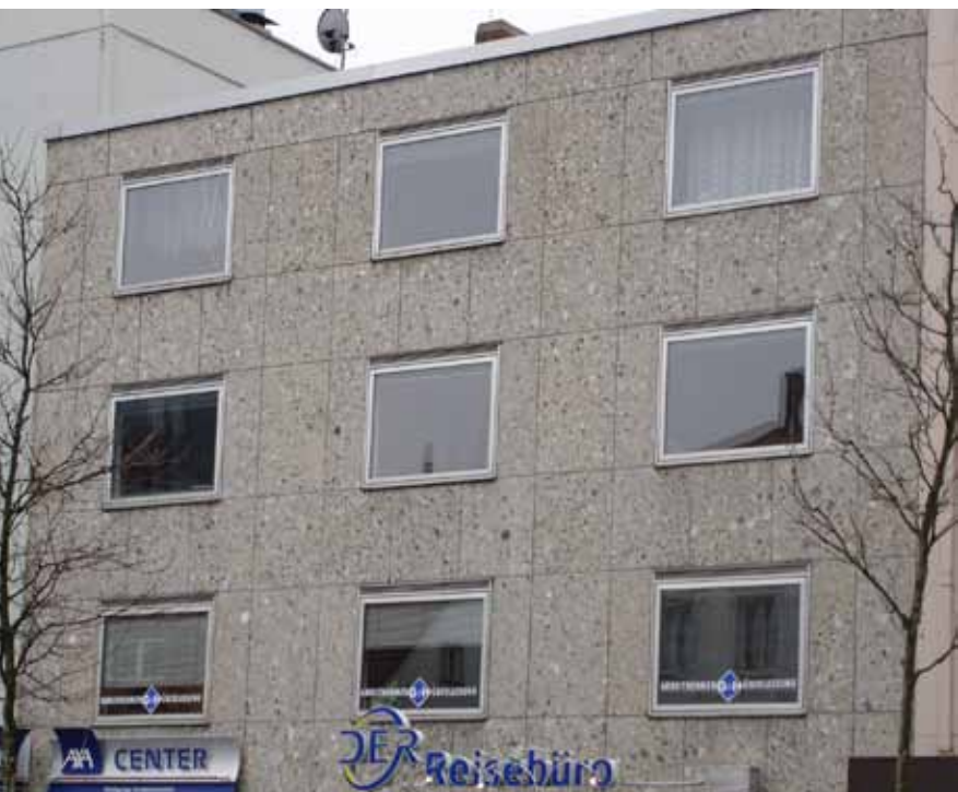
▲ Abb. 4. Großflächige Fassadenverkleidung aus Brannenburger Nagelfluh am Gebäude Stadtgraben 49.
