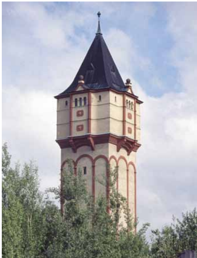
▲ Abb. 6. Der 63 m hohe Wasserturm östlich des Stadtzentrums diente ab 1922 der Wasserversorgung der Innenstadt und wird heute noch als Druckausgleichsbehälter genutzt.
