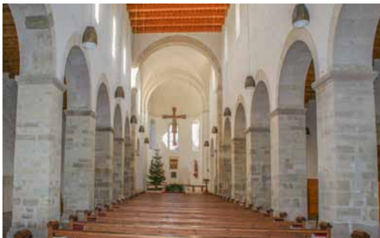
▲ Abb. 10. „Reromanisierter“ Innenraum der Peterskirche mit Pfeilern aus Mettener Granit und Kelheimer Jurakalkstein. Vereinzelt finden sich Blöcke von Regensburger Grünsandstein im Mauerwerk. Foto: G.L.
