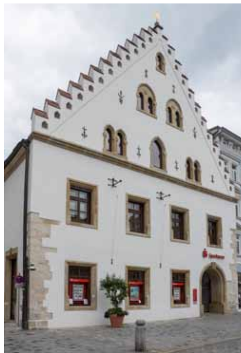
▲ Abb. 9. Geschäftsstelle der Sparkasse Niederbayern Mitte im ehem. Kastenamt. Modernisierte Fassade des ursprünglich gotischen Gebäudes mit Fenster- und Türleibungen aus Bucher Sandstein und freigelegten Eckblöcken aus Kelheimer Kalkstein und Mettener Granit. Foto: G.L.
