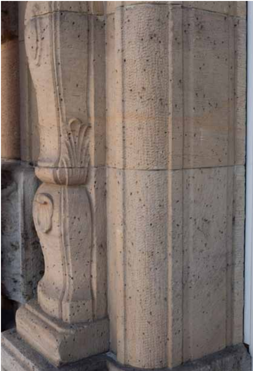
▲ Abb. 16. Detail des Sandsteinportals mit blasigem, beige-braunem Sandstein, bisher unbekannter Provenienz. Foto: G.L.
