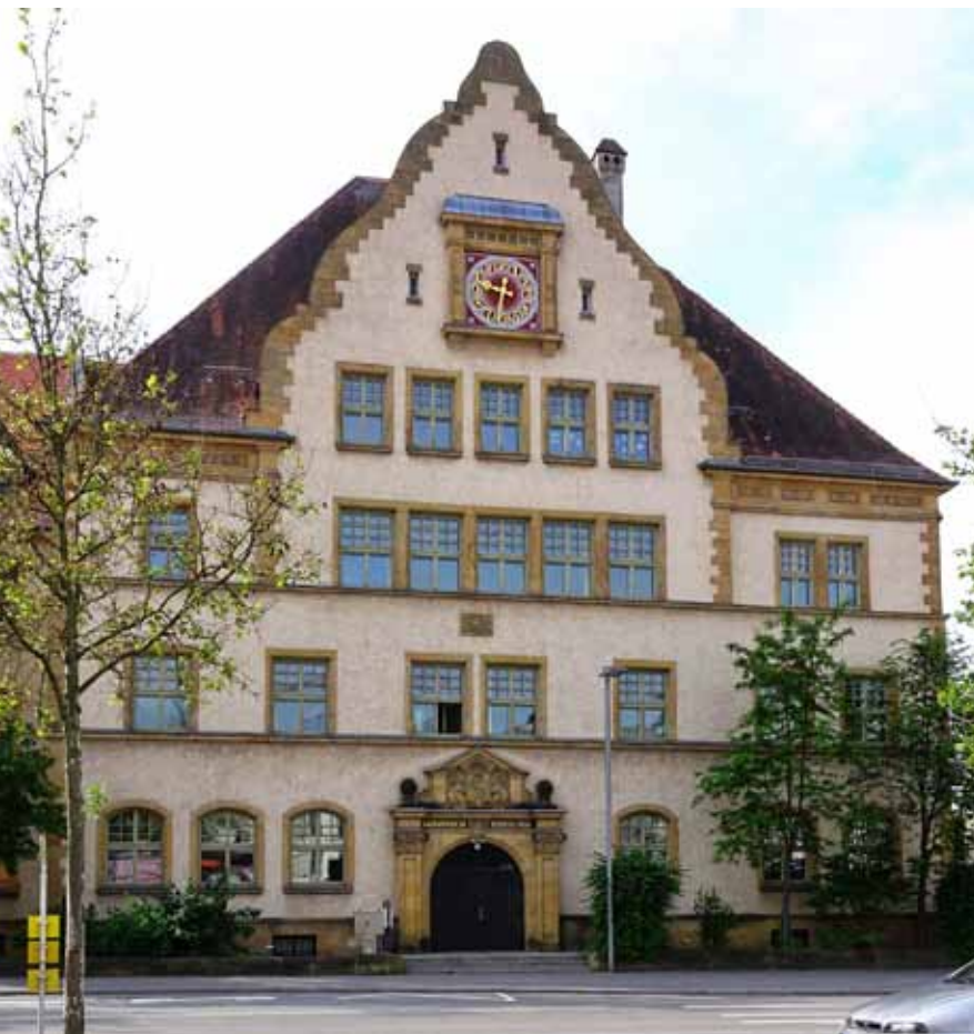
▲ Abb. 3. Fassade der heutigen Mathias-von-Flurl-Schule mit Werksteinelementen aus kreidezeitlichem Erzhäuser Sandstein aus der Bodenwöhrer Senke (Foto: Peter Schwarz).
