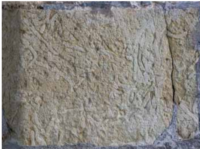
▲ Abb. 9 (oben). Durchgang unter dem Stadtturm von der Nordseite. Das Gewölbe besteht aus Blöcken von Regensburger Grünsandstein, der stark überstrichen ist und daher an manchen Stellen wie ein Kalkstein aussieht. An vielen Blöcken sind Steinmetzzeichen zu erkennen. Foto: G.L.
