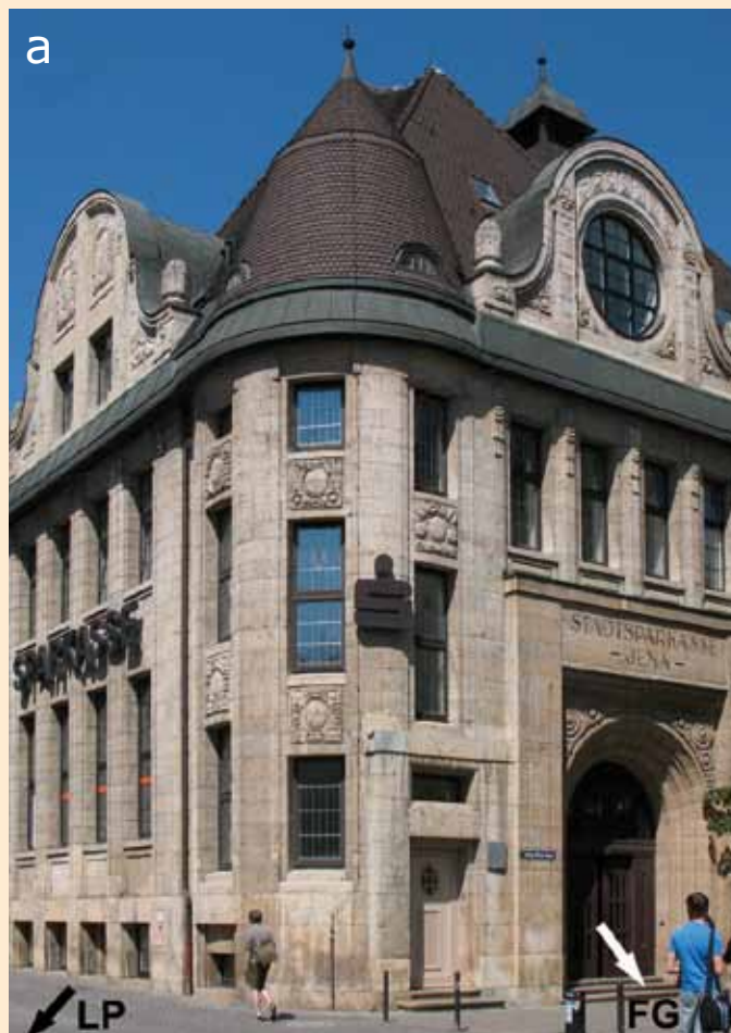
Abb. J - 3: Punkt 1 - Gebäude der Stadtparkasse, Fassade aus Jenaer Kalkstein.
