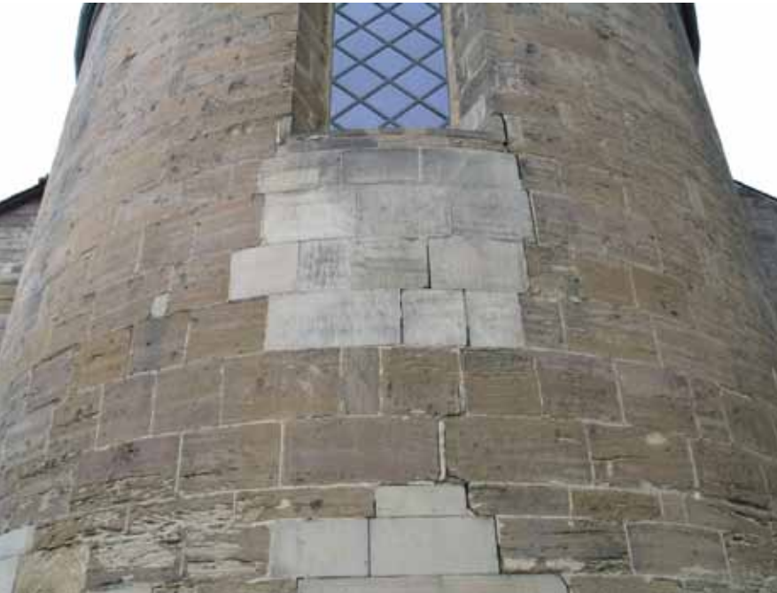
▲ Abb. 13. Im romanischen Westteil der Klosterkirche sind hellbraune Sandsteine mit rötlicher Marmorierung zu erkennen, die vom Kraftsdorfer Sandstein abweichen. Sie gehören zum Dolomitischen Sandstein der oberen Bernburg-Formation, der in der Umgebung ansteht. Bei der späteren Restaurierung wurden die Fenster verkleinert und eine Pforte im Chor zugemauert. Dafür verwendete man helle Sandsteine der Solling-Formation.
