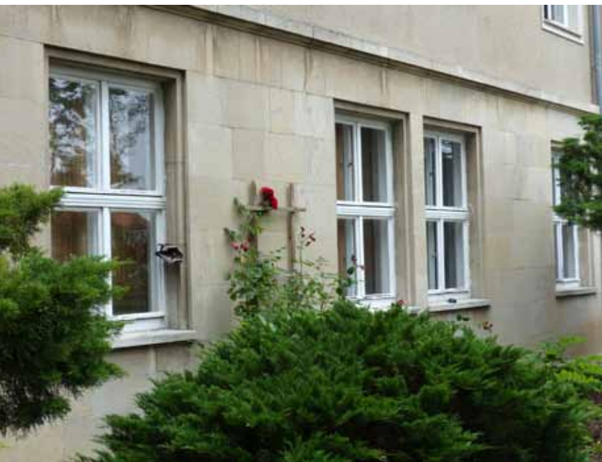
▲ Abb. 6. Die Fassade des Instituts wurde am Sockel mit angeschliffenen Platten aus Naumburger Schaumkalk verkleidet.
