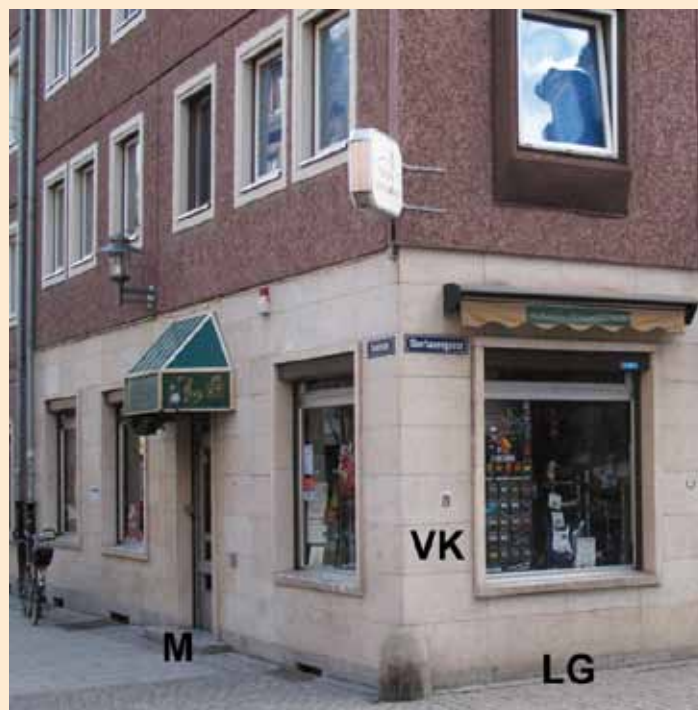
Abb. J - 10: Punkt 14 - Saalstraße 12:
