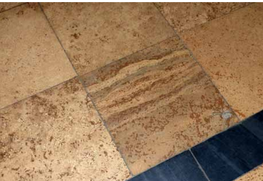
▲ Abb. 3. Im Foyer werden Bodenplatten aus gespachteltem Travertin mit geschliffenen Dachschieferplatten eingefasst.
