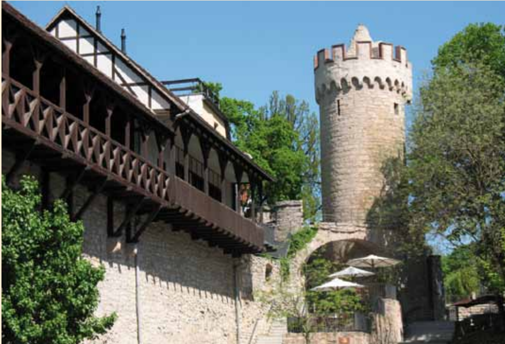
Abb. J - 1: Reste der Jenaer Stadtmauer mit Pulverturm aus Jenaer Kalkstein , rote Zinnenumrandung aus Rochlitzer Porphyrtuff (siehe auch Punkt 34) [Foto: Schirrmeister]
